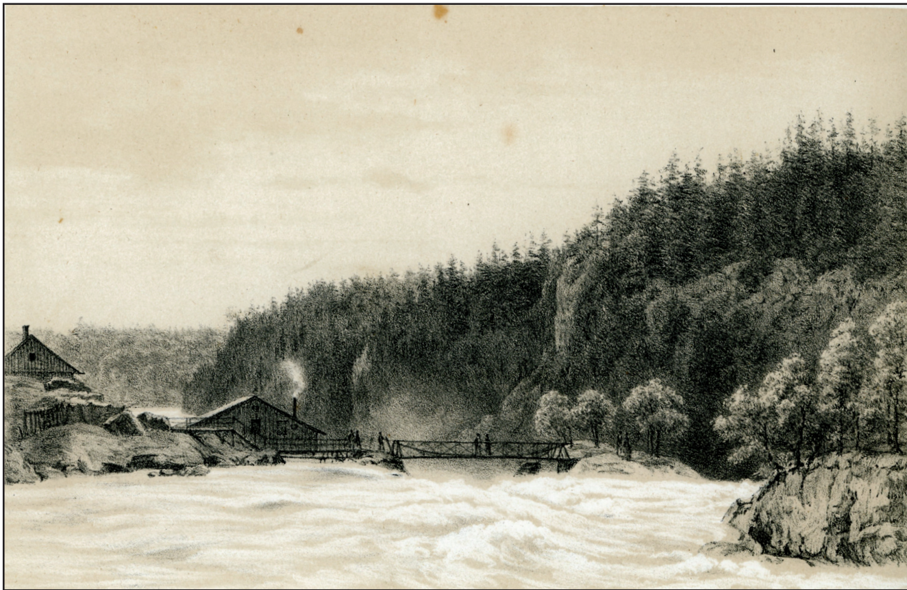
Bron mellan Önan och Toppön över östra Toppöfallet
