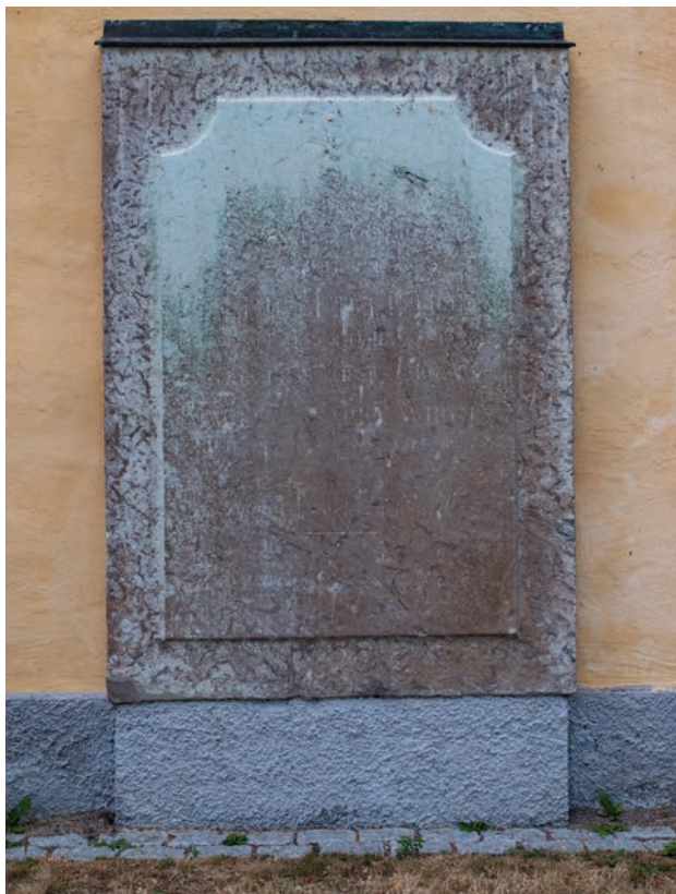
Landshövdingeparet Lilliehorns gravhäll uppsatt på östra ytterväggen på Vänersborgs kyrka. Kalkstenshällen är i dag mycket nött och inskriptionen kan endast med svårighet läsas.
