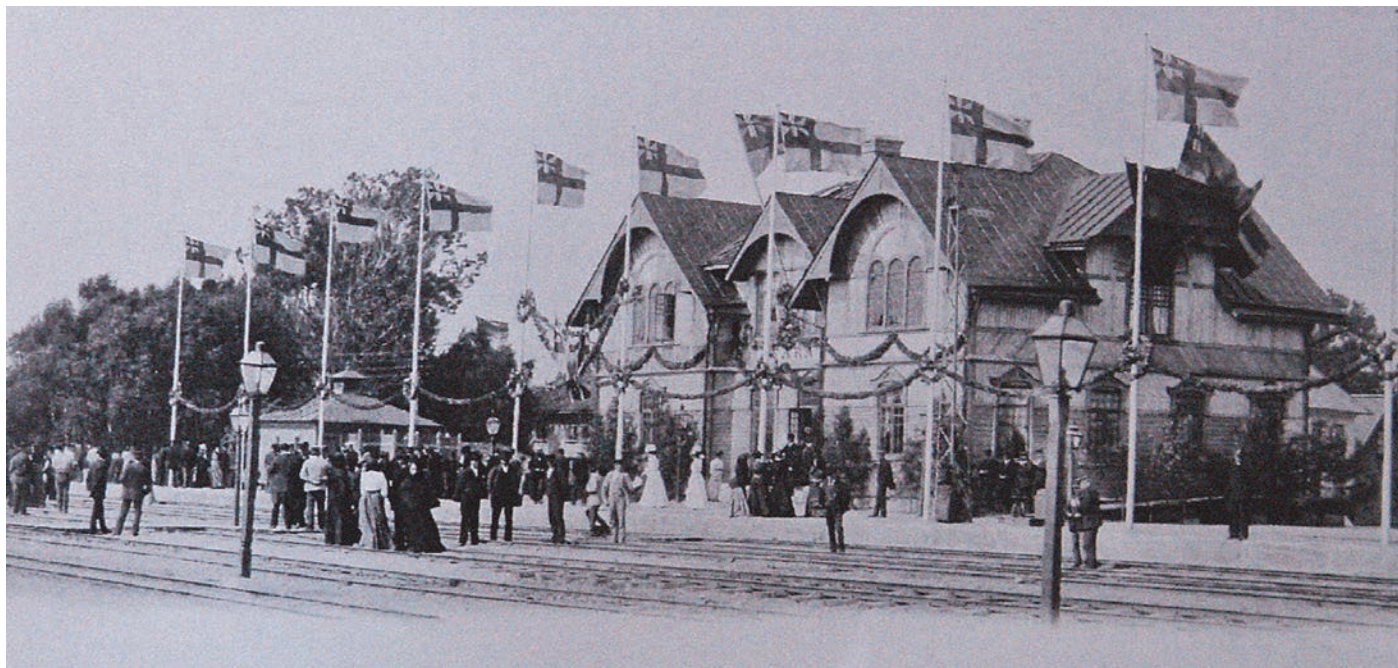
Vara järnvägsstation med all sin snickarglädje vid invigningen av Västgötabanan 1900.
