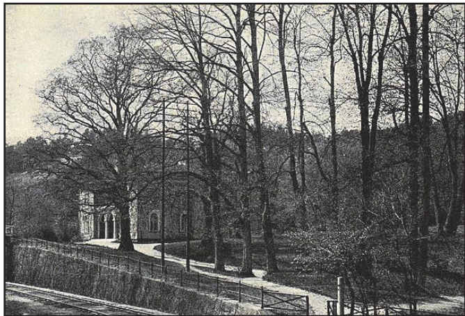
Villa Bokedalen revs 1960. Det tidigare idylliska läget tycks blivit fördärvat av järnvägen redan 1856.
